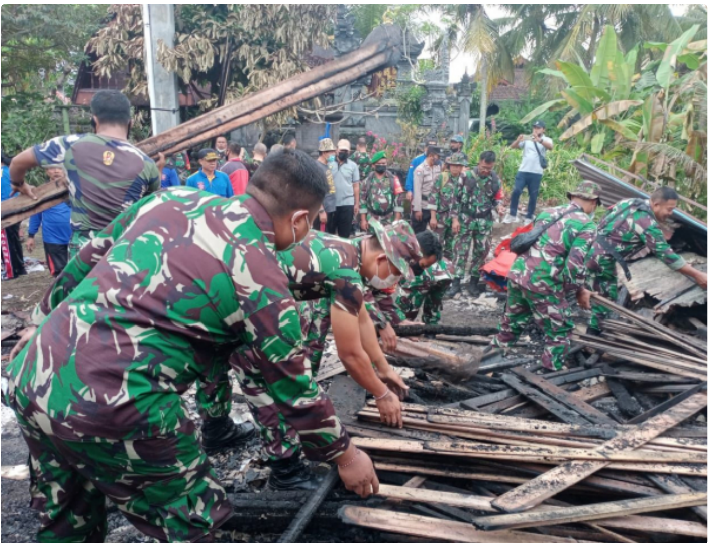
Bersihkan sisa puing-puing bekas kebakaran
